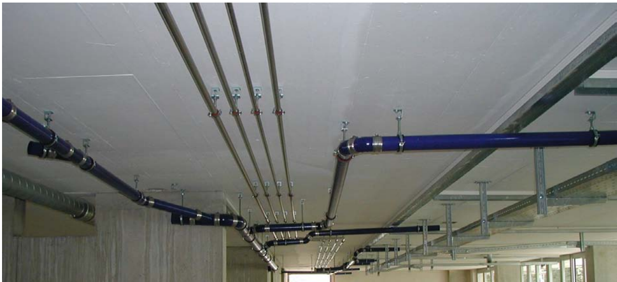
Imagen 8, Instalación hidro-sanitaria segura
