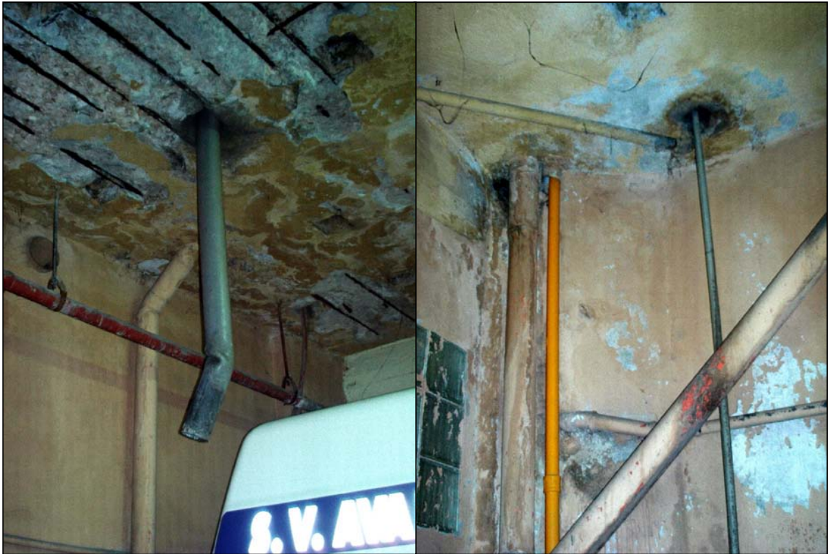
Imágenes 3 y 4, Daños causado por filtraciones en un edificio de hormigón armado
